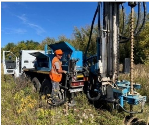
Рисунок 1 – Инженерно-геологические работы с применением буровой установки УРБ-51 на базе автомобиля Урал
