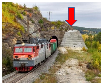
Рисунок 6 – Тоннель «За» Красноуфимская дистанция пути, после ремонта проведенного на основании описываемого комплексного обследования
