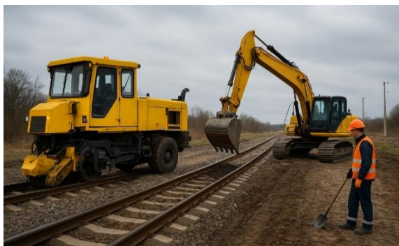
Рисунок 1 – Капитальный ремонт железнодорожного пути с применением современной путевой техники
