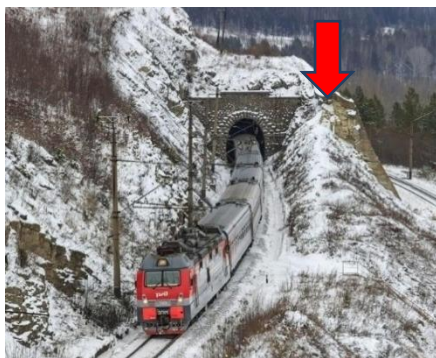
Рисунок 5 – Тоннель «За» Красноуфимская дистанция пути, до проведения изысканий и ремонта
